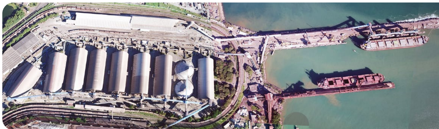
Vista aérea do Terminal de Tubarão (ES)
